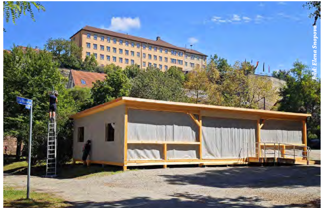
Von der Breisacher Holzhausfabrik sind die neuen Weinlauben konzipiert und aufgebaut worden
