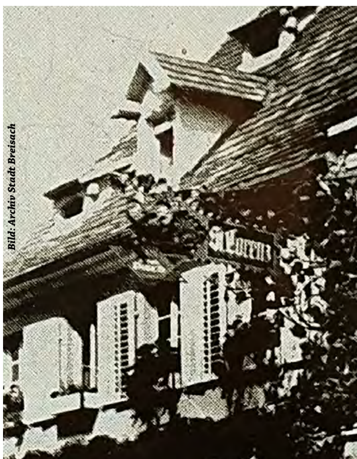
Ehemaliges Gasthaus St. Lorenz, Neutorstraße 7 Breisach
