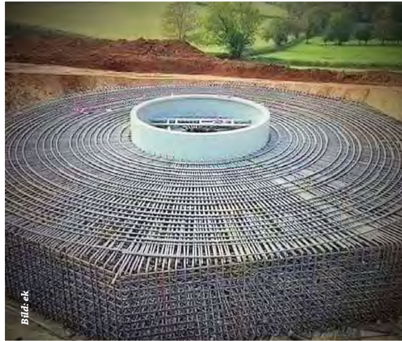
Stahlbewehrung im Sockel einer Windkraftanlage
