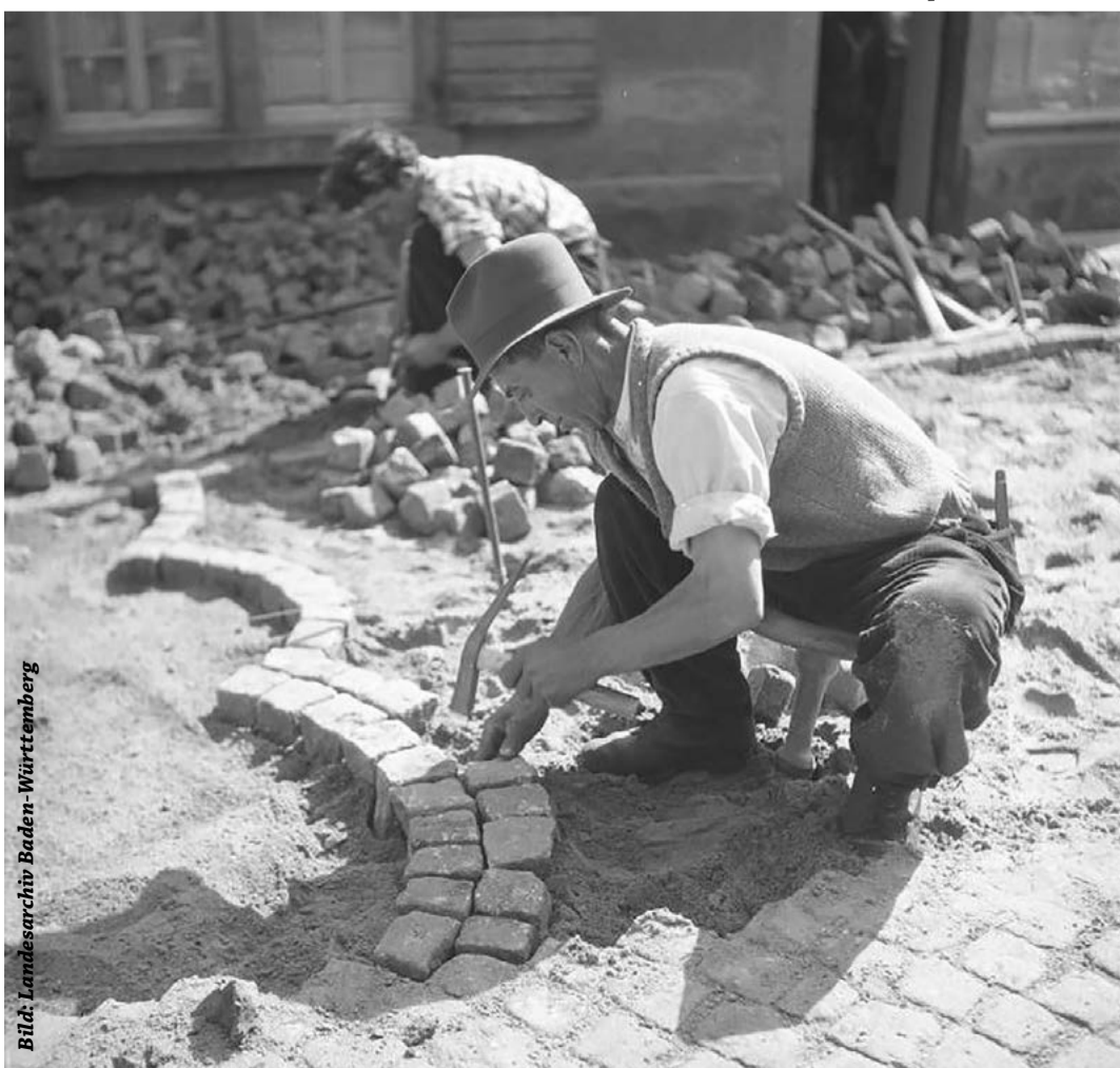
1950: Pflasterer oder Steinleger im Einsatz in Freiburg
