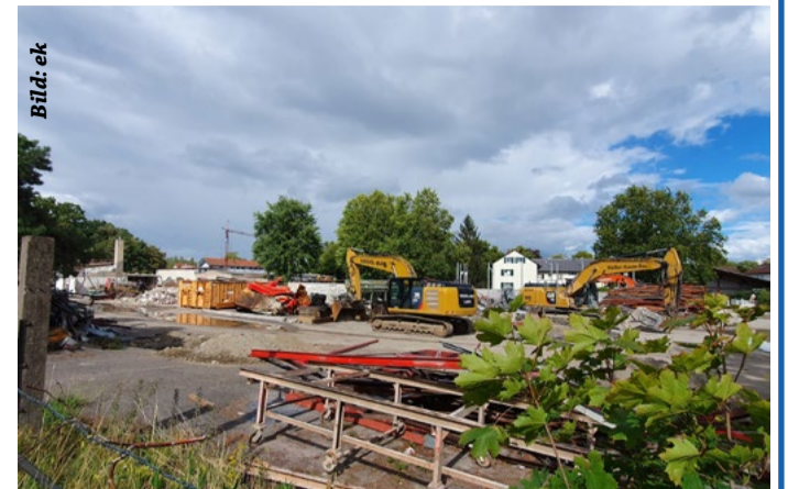
Ehemaliges Produktionsgebäude von Birkenmeier in der Hafensstraße
