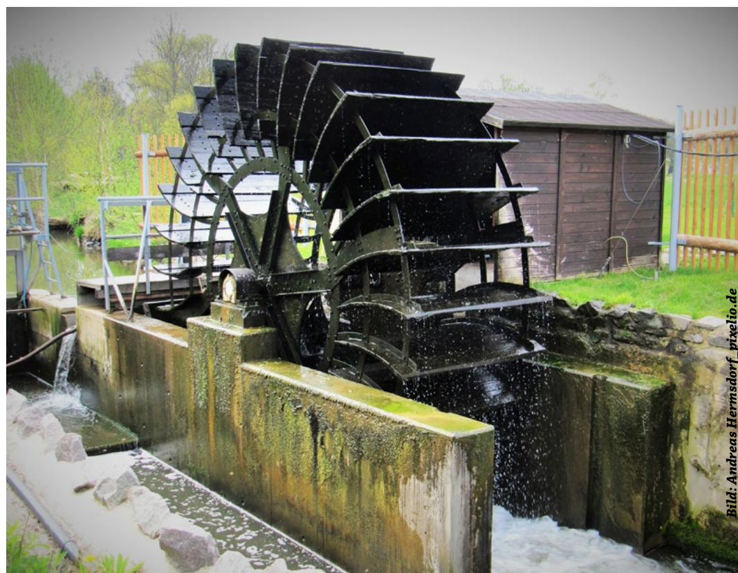
Bis heute klappern die Mühlen am rauschenden Bach
