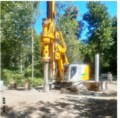
Für den Bau einer Brücke für den Hochwasserrückhalteraum werden Bohrpfähle gesetzt
