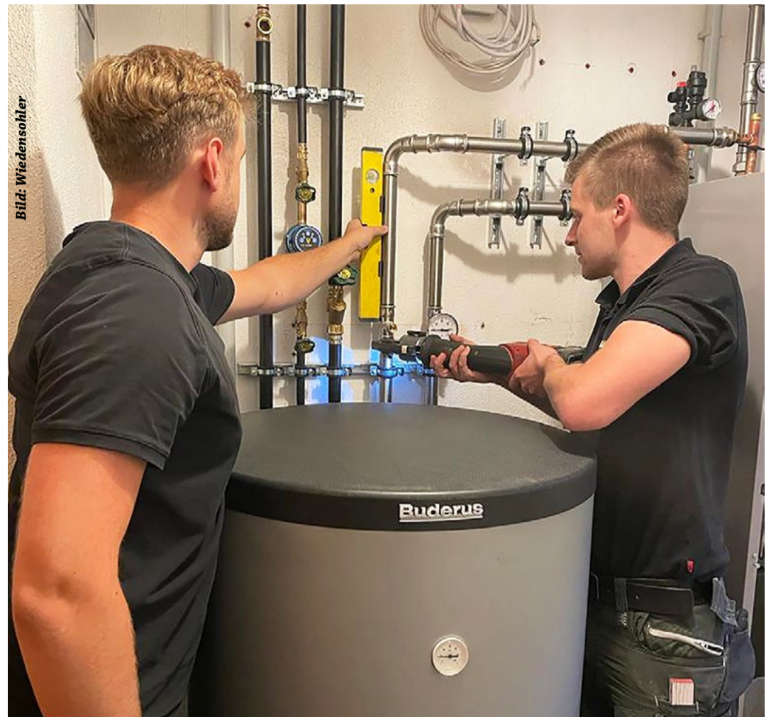
Moderne Sanitär-, Heizungs- und Klimatechnik
