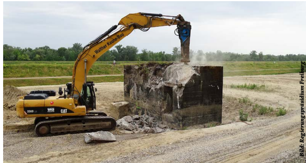
Mit dem Meißel eines Spezialbaggers wurden die schweren Betonmauern zerlegt
