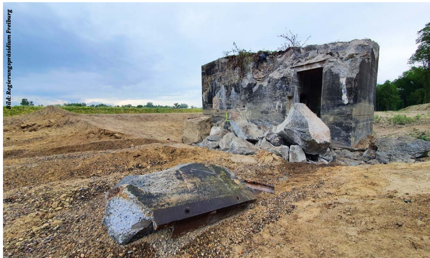
Mauerreste wie eine Panzertür (im Vordergrund) sollen an die steinerne Brutalität des Breisacher Nazi-Westwallbunkers erinnern
