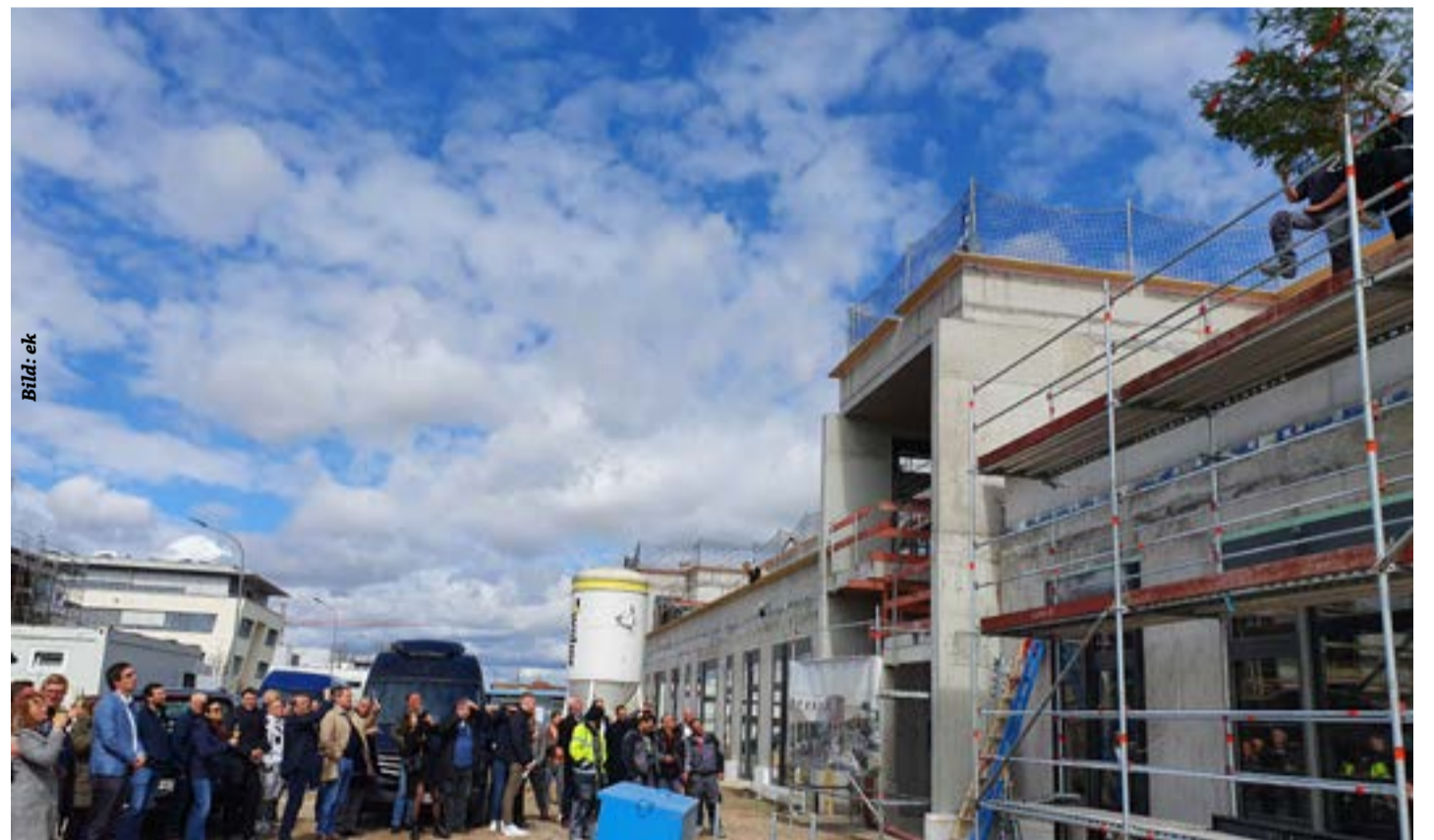
Halbzeit beim Neubauprojekt VitaRhena im Breisacher Gewerbepark Rheinbrücke. Viele Gäste sahen sich direkt vor Ort um
