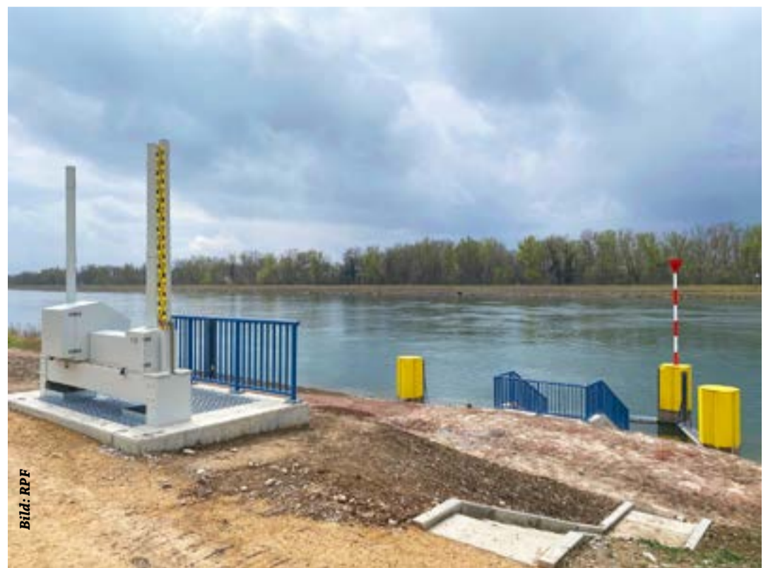
Das kleine Einlassbauwerk ist größtenteils in den Rheinseitendamm eingebaut worden - deshalb ist an der Oberfläche nicht viel zu sehen.
