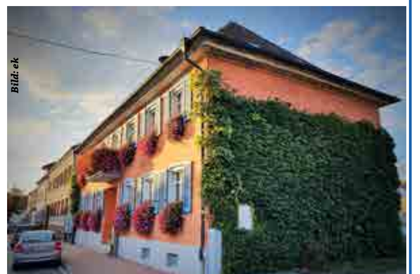
Das beschauliche Rathaus in Sasbach wird barrierefrei umgebaut und erweitert
