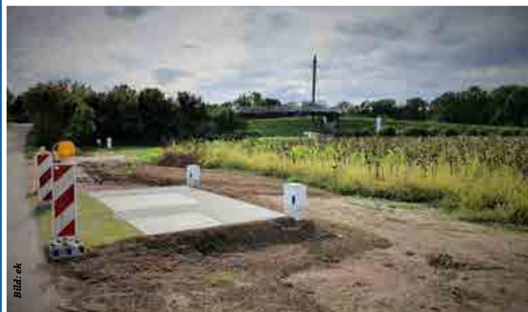
Der Hochwasserschutz im Raum Breisach ist durch neue Brunnenanlagen optimal gesichert
