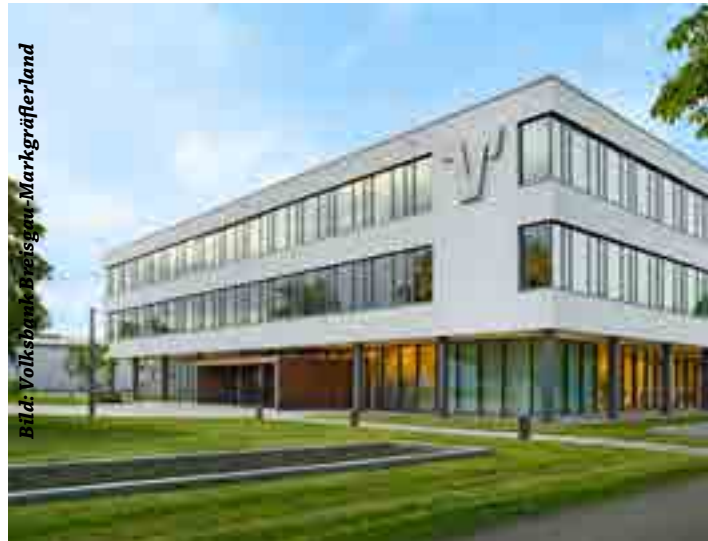
Im Gewerbepark Breisgau befindet sich die Volksbank-Zentrale
