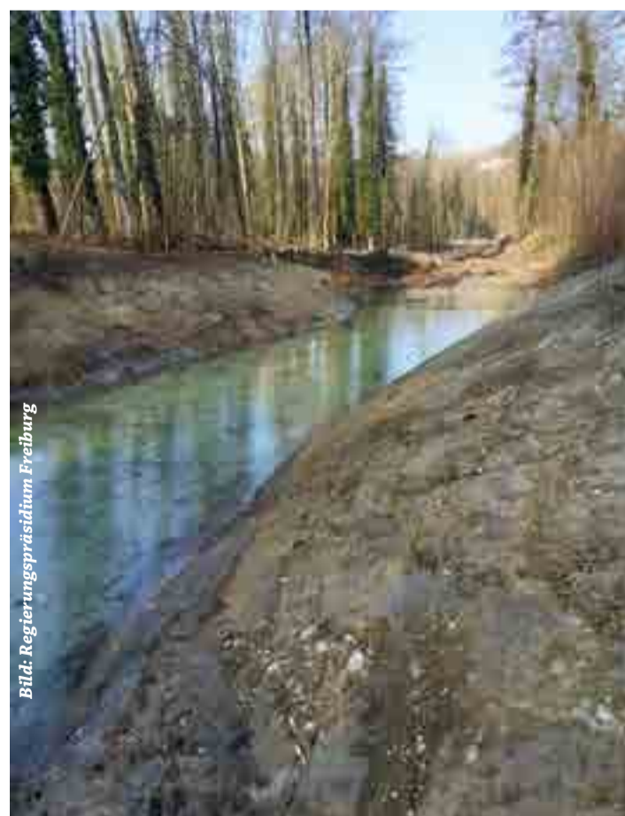
Der Aushub des Blauwasserbetts ist weit vorangeschritten
