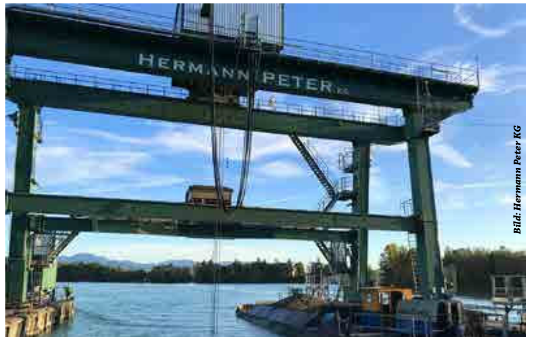
In der erweiterten Kiesgrube soll im Frühjahr 2021 der erste Kies gewonnen werden
