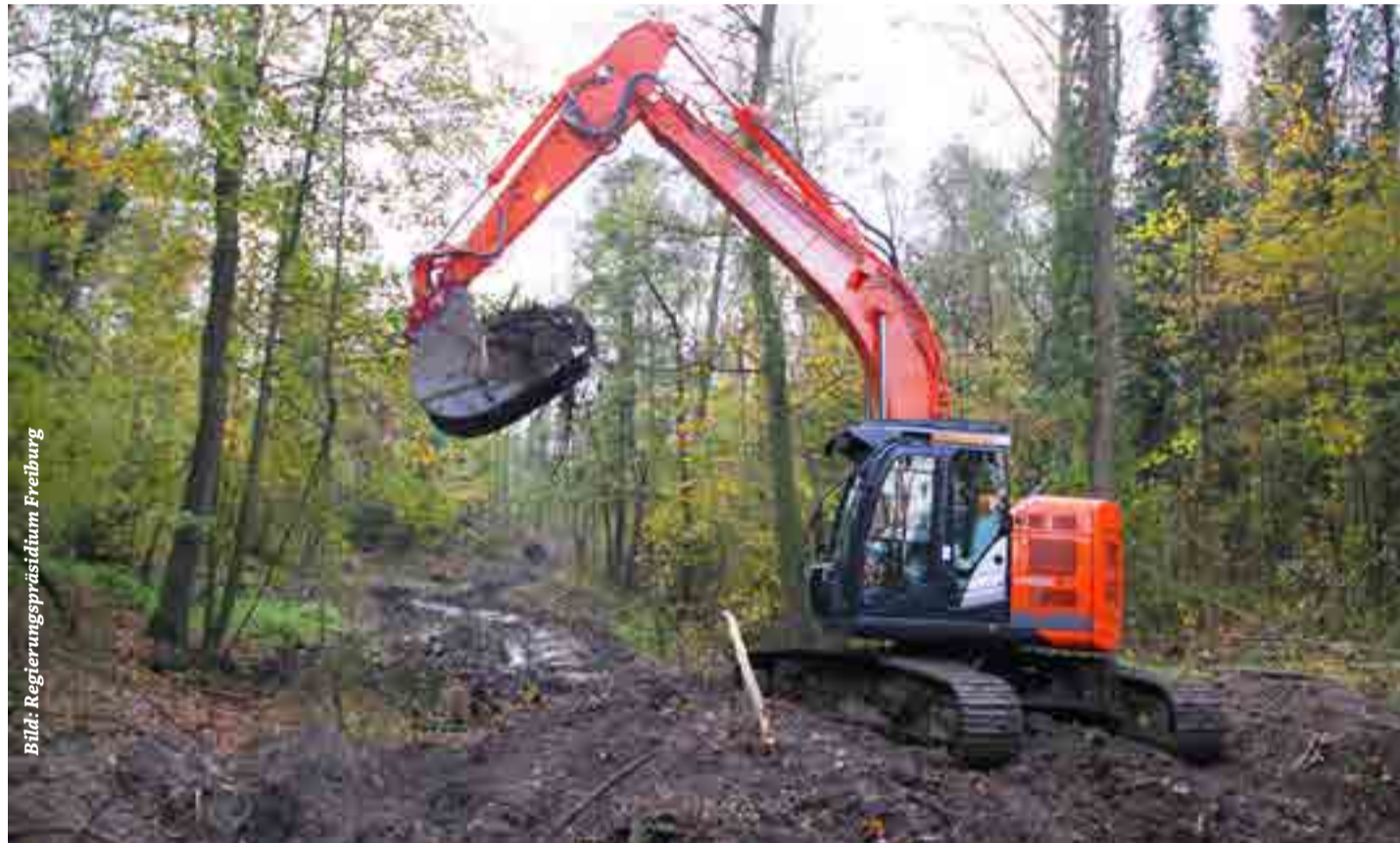
Laufende Baggerarbeiten zur Modellierung des alten Blauwasserbetts (September-2020)
