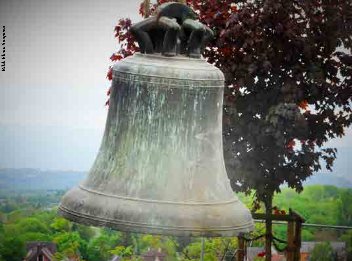
Ausbau der Glocken des Breisacher Münsters zu Beginn der Glockenstuhlsanierung
