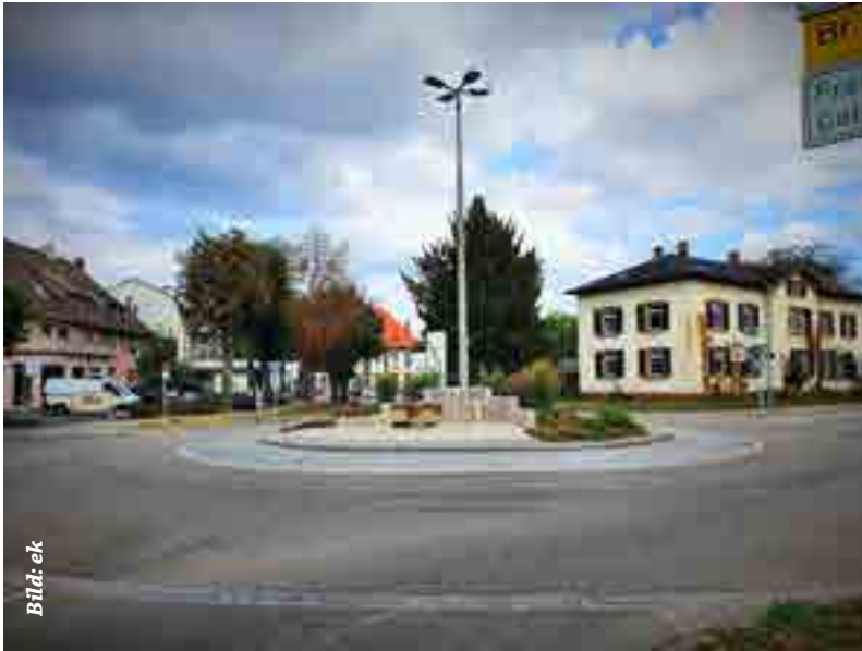
An diesem Kreisverkehr wird es künftig vier Fußgängerüberwege geben
