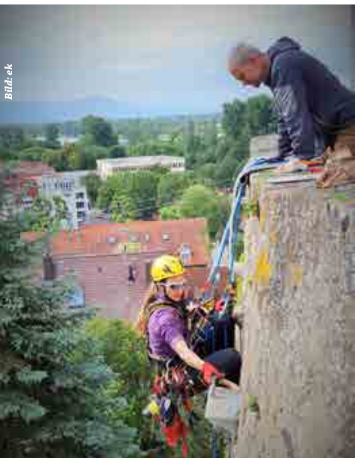
Einblick in die Sanierungsarbeit der Stadtmauern
