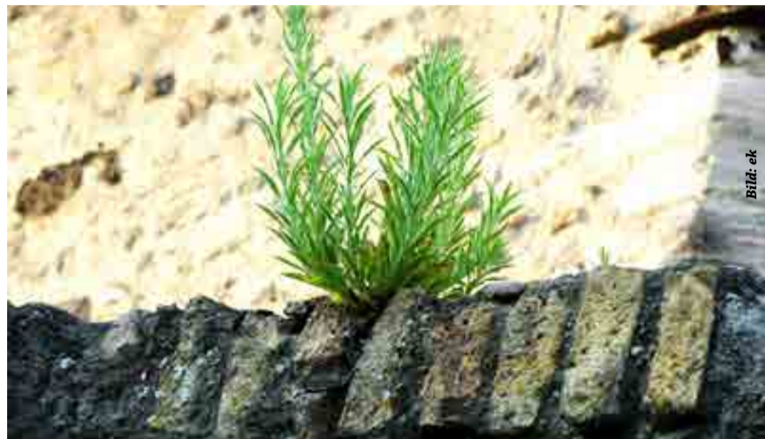
Krautiger Bewuchs schadet dem Mauerwerk nicht unbedingt
