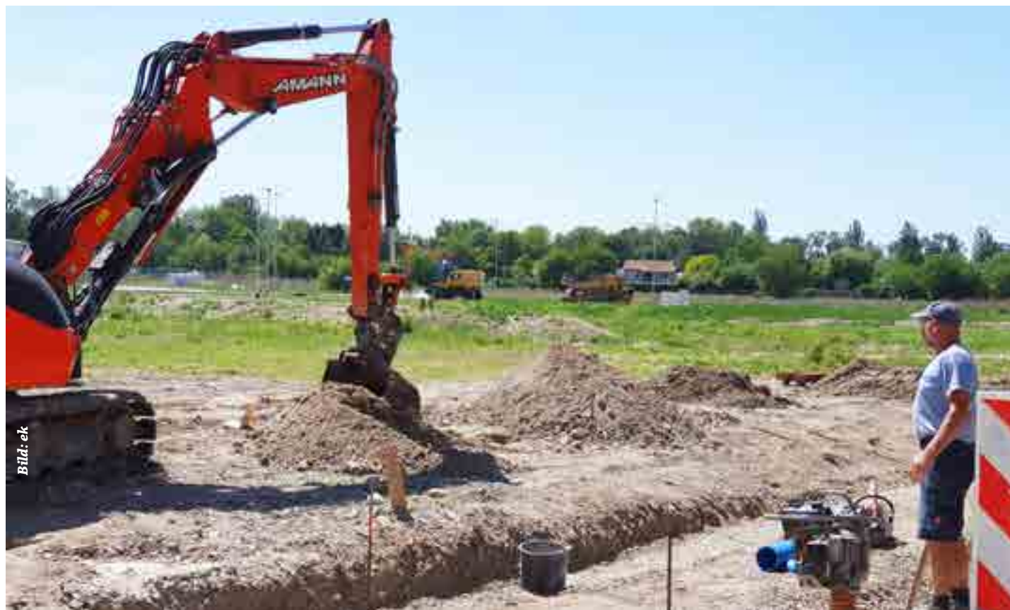
Im Baugebiet in der Vogesenstraße in Breisach gehen die Erschließungsarbeiten zügig voran
