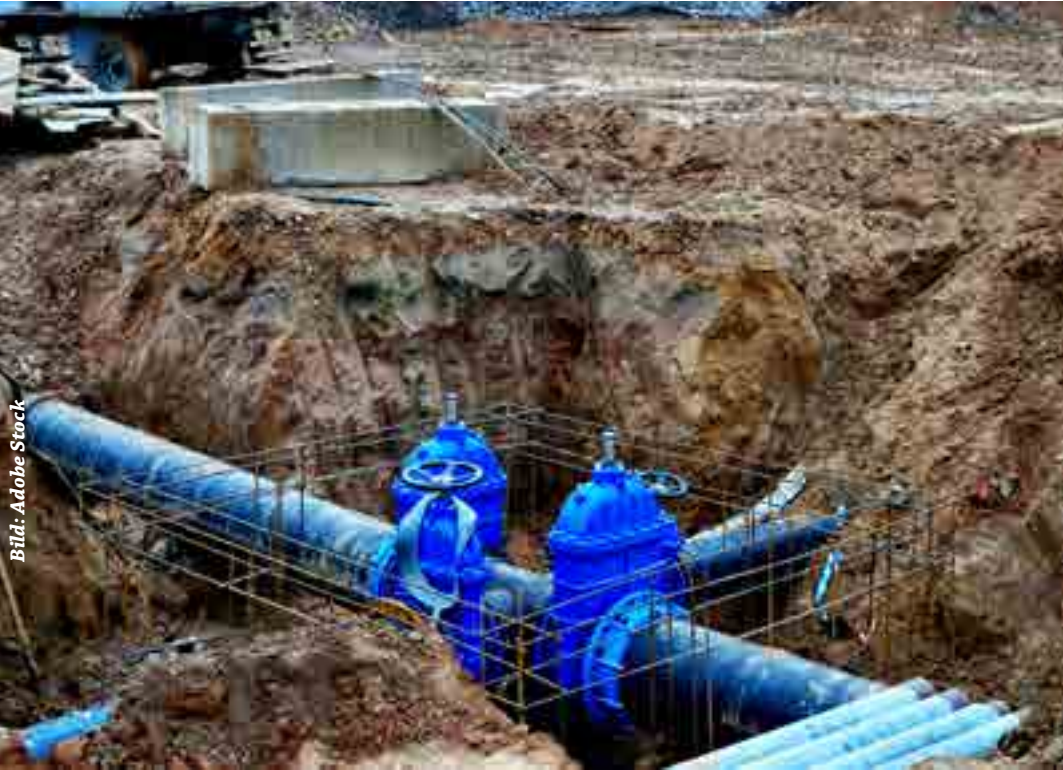
Die Breisacher Wasserleitungen werden mit dem Wasser aus Hausen entlastet
