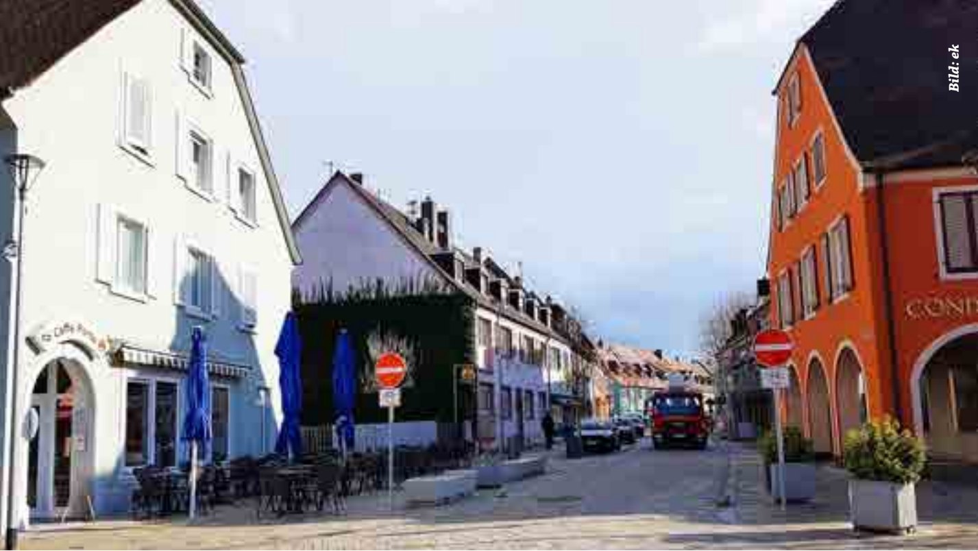
Auch links und rechts der Rheinstraße werden noch Stühle zurecht gerückt werden müssen, wenn sich erst das 37 Zentimeter breite Blindenleitsystem verkehrssicher auf dem Gehweg durchschlängelt
