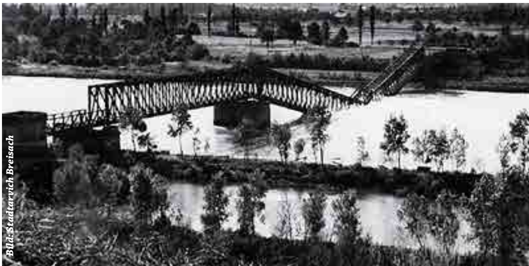
Die am 12. Oktober 1939 von französischen Pionieren gesprengte Eisenbahnbrücke Breisach. Bild aus: Scharf 2003
