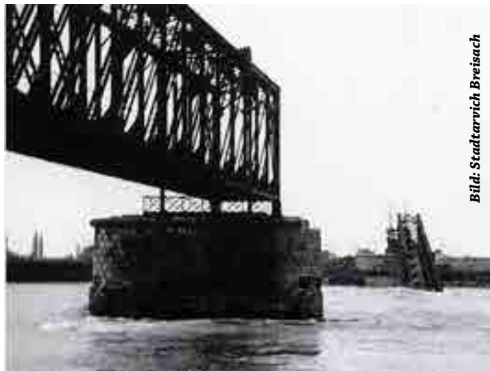
Zerstörte Breisacher Brücke nach der am 20. Oktober 1939 erfolgten Sprengung durch deutsche Pioniere. Bild aus: Scharf 2003
