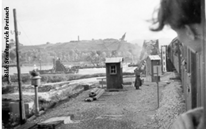
Breisacher Rheinbrücke nach dem 25. Juli 1940, aus dem Zug fotografiert von der elsässischen Seite aus vor der Behelfsbrücke. Im Hintergrund der Eckartsberg, links von der wiederaufgebauten Eisenbahnbrücke sind die Trümmer der alten Brücke im Rhein zu sehen. Außerdem erkennt man zwei Wachhäuschen und zwei Soldaten. Die Aufnahme müsste perspektivisch von einem Zuginsassen gemacht worden sein.
