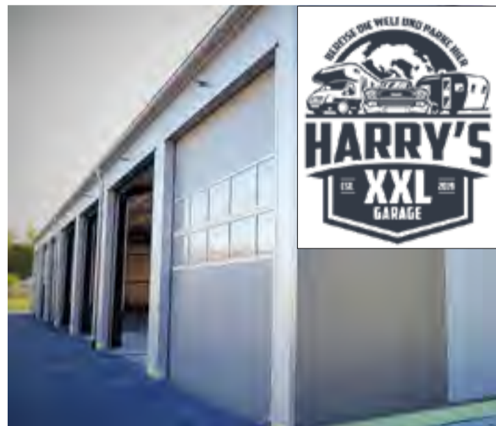
Die XXL-Garage schließt eine Lücke in Breisach
