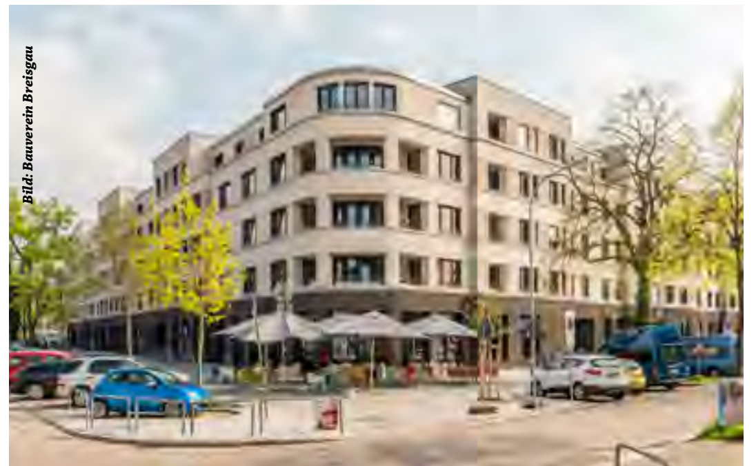
Das Uni-Carree setzt im Stühlinger einen deutlichen städtebaulichen Akzent
