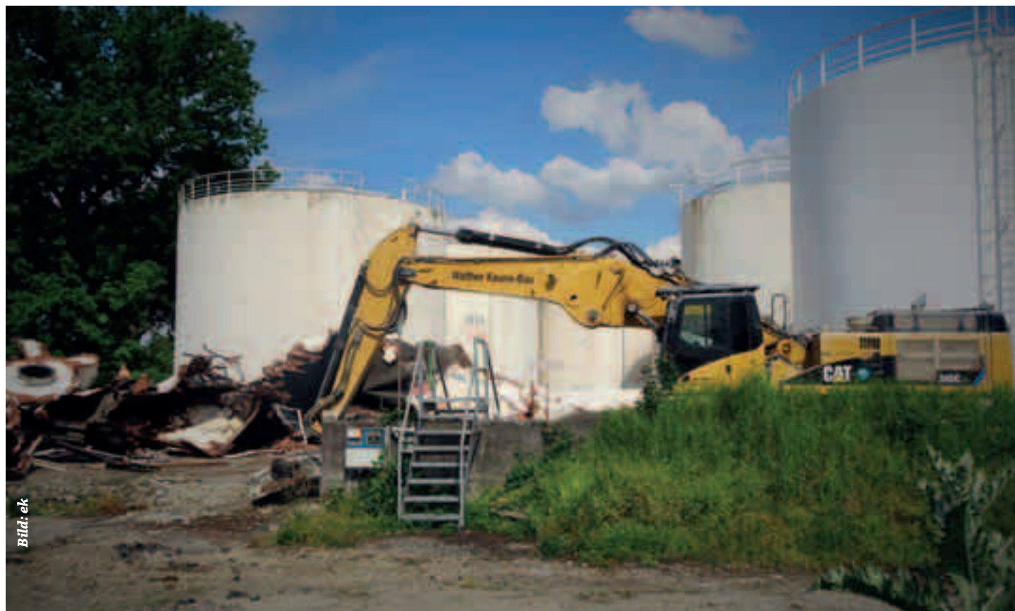
„Rückbau“ nennen die Fachleute den aufwändigen Abbruch des alten Tanklagers am Breisacher Hafen
