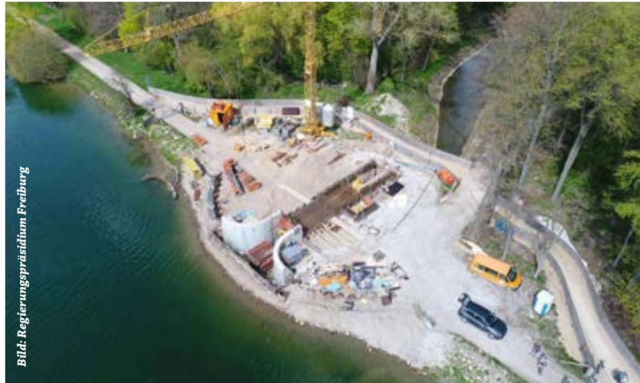
Luftbildaufnahme des Einlaufbauwerks im Süden während der Bauzeit mit sichtbarem Anschluss der bestehenden Schlut
