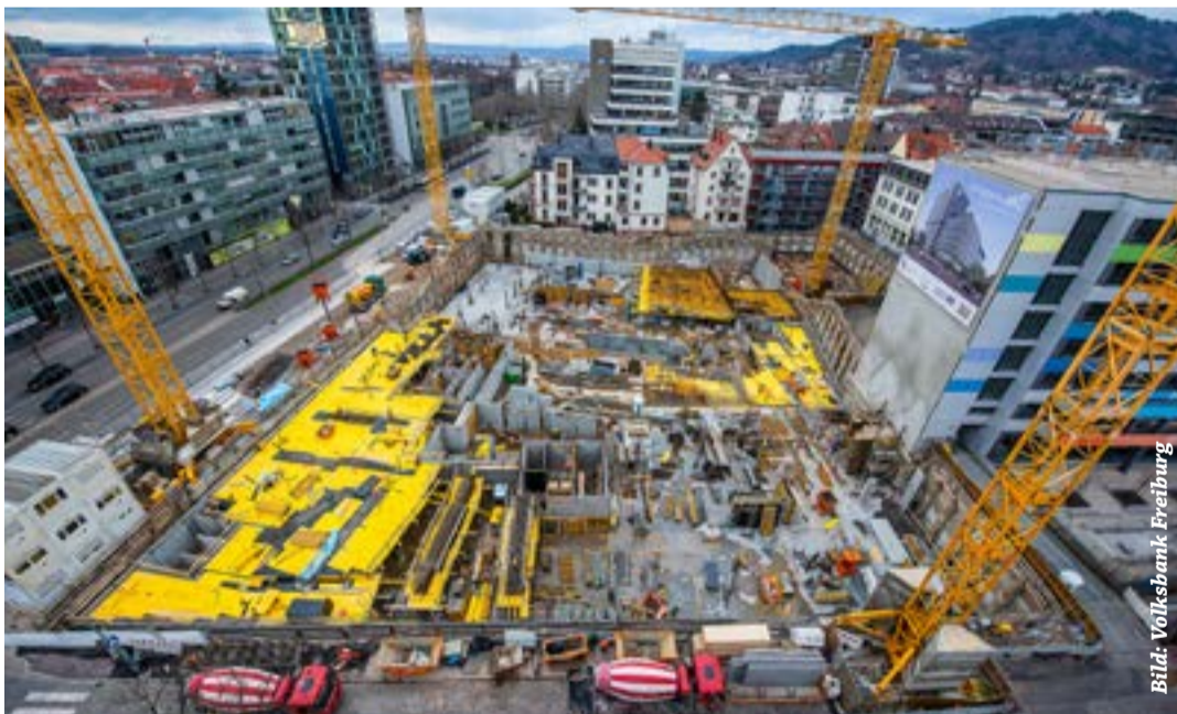
Großprojekt an der Freiburger Bismarckallee: der Neubau der Volksbank Freiburg wächst aus dem Boden
