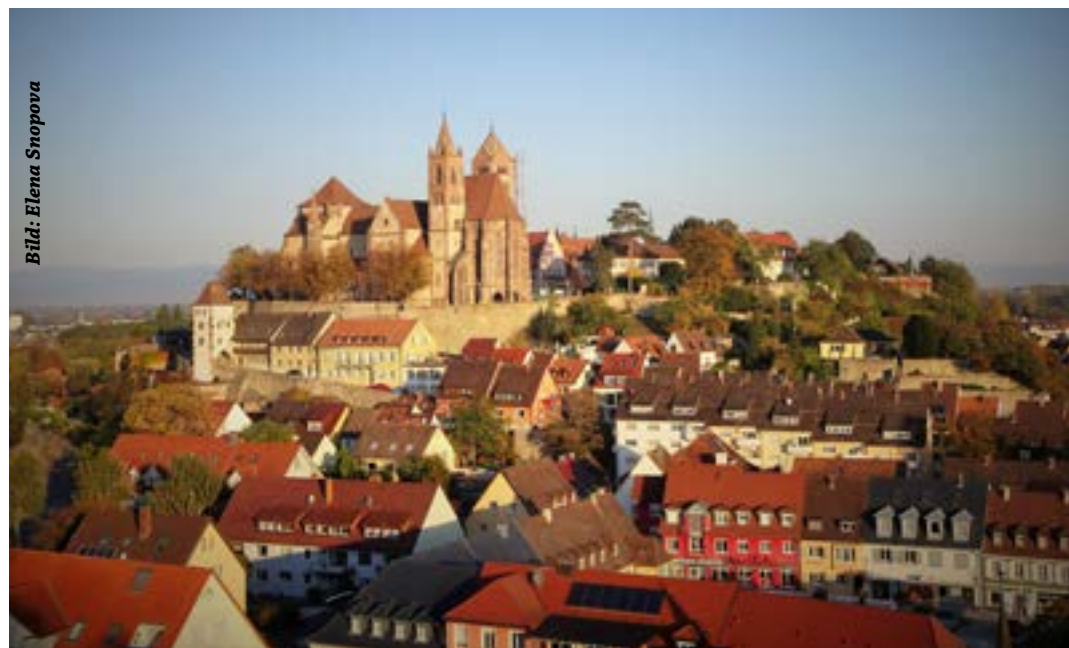
Eine Million Euro Investitionen stehen im Breisacher Haushalt
