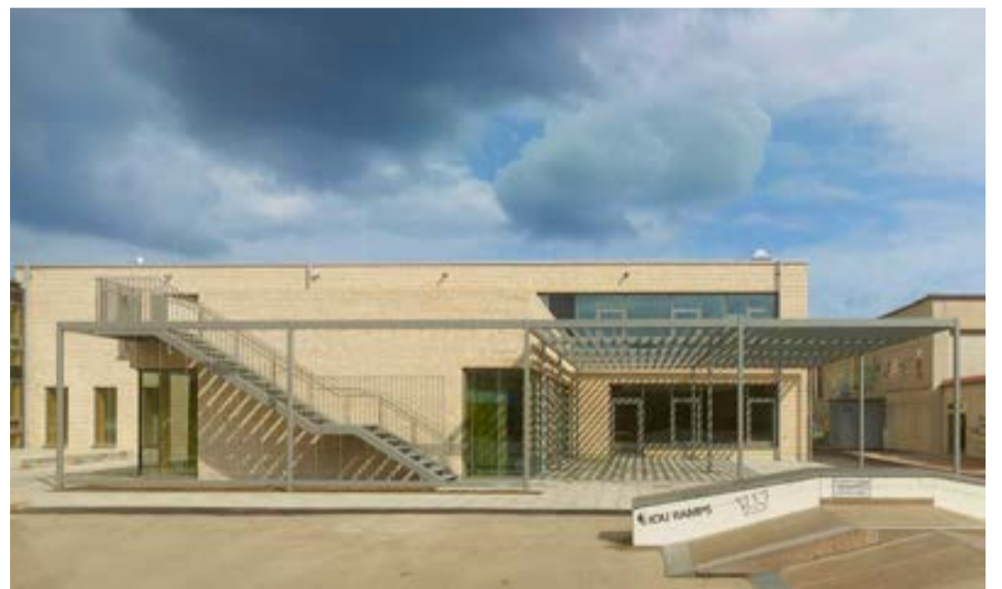
Ein Blick auf den Neubau der Neunlindenschule in Ihringen
