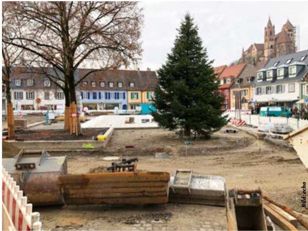
Die Bauarbeiten am Breisacher Marktplatz gehen zügig voran - gerade in diesen milden Wintertagen
