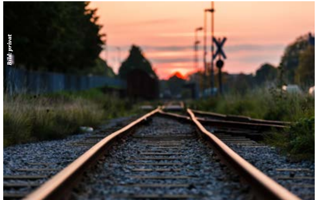
Leicht deformierte Schienen wurden durch die starke Hitze verursacht
