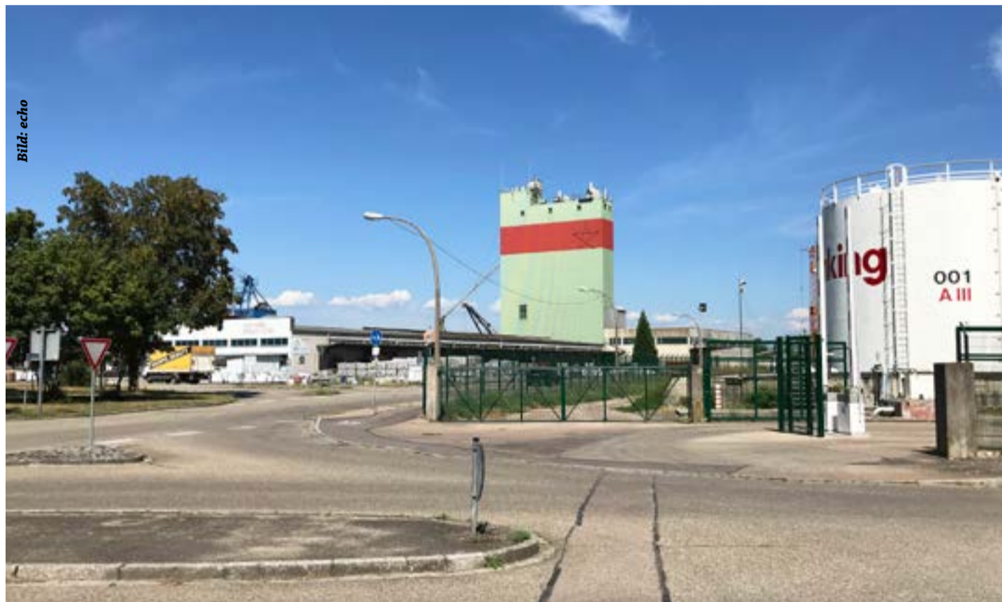
Der Abzug des Tanklagers am Rhein bedeutet gleichzeitig eine große städtebauliche Chance für die Stadt
