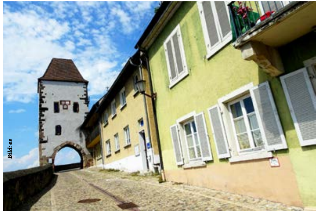
Sanierung bis 2023 Gebäude Münsterbergstraße 28 bis 32 (vor dem Hagenbachturm). Im Vordergrund das städtische Haus Münsterbergstraße 26, das ebenfalls sanierungsbedürftig ist
