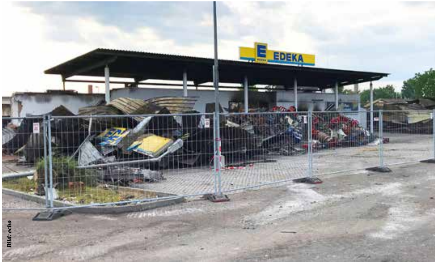
Ein verheerendes Bild bot Ende der Woche noch das ausgebrannte Edeka-Gebäude an der Ihringer Landstraße in Breisach
