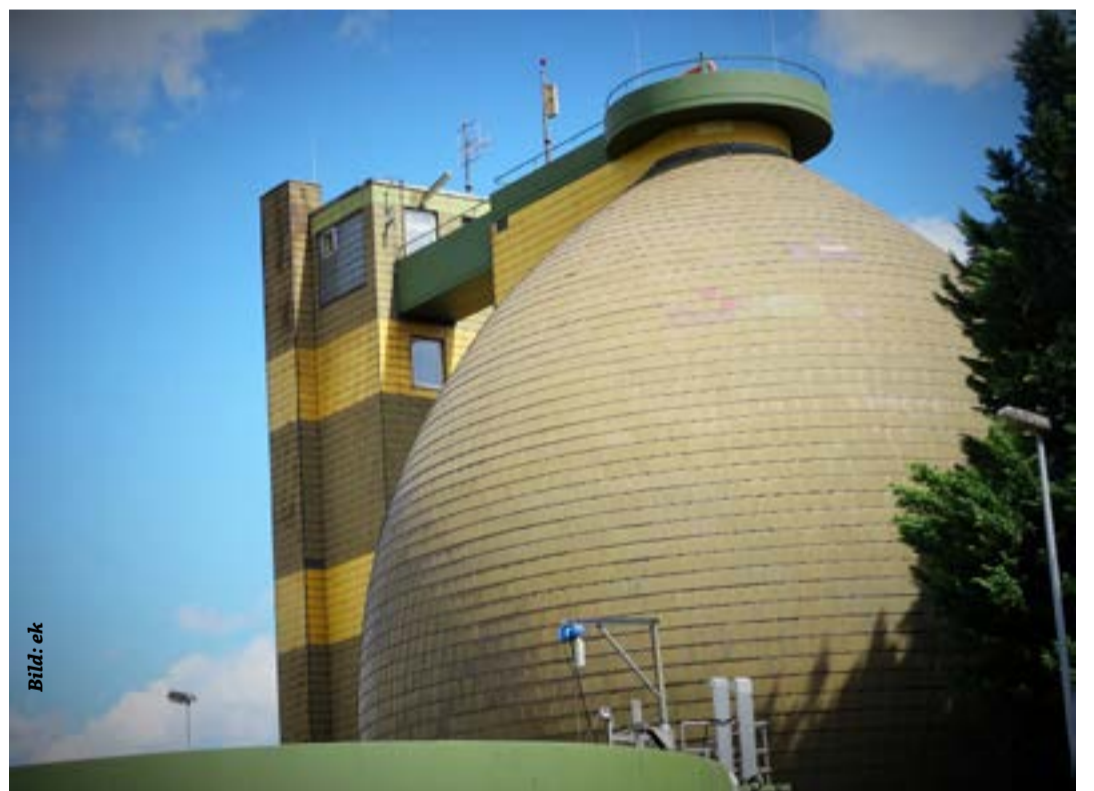
Hohe Aufwendungen für den reibungslosen Betrieb der Breisacher Kläranlage
