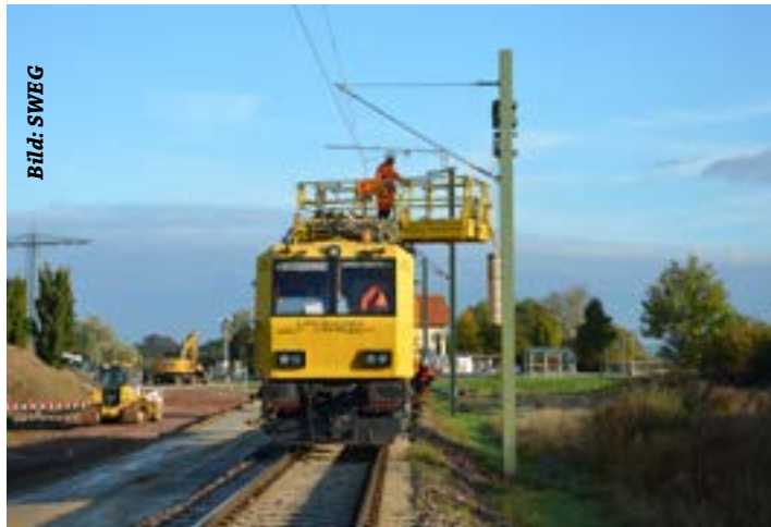
Meter für Meter werden die Oberleitungen verlegt
