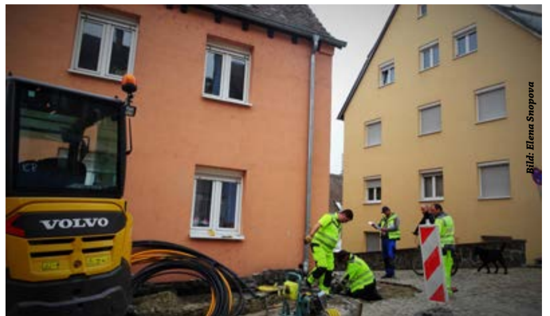
Überall in Breisach werden derzeit Straßen aufgerissen - es geht ums schnelle Internet
