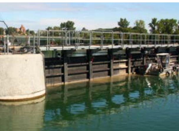
roll- oder Revisionsarbeiten in einem Abschnitt des Wehres installiert wird. Dazu wird er im Oberwasser des Rheins am Wehr versenkt, verankert und danach als Arbeitsraum von Wasser leergepumpt, wodurch der Wehrboden in diesem Bereich frei zugänglich wird. Der Zustand von Beton und Stahl des Kulturwehres kann dann ohne Taucher überprüft werden. Möglich wäre diese ge-
