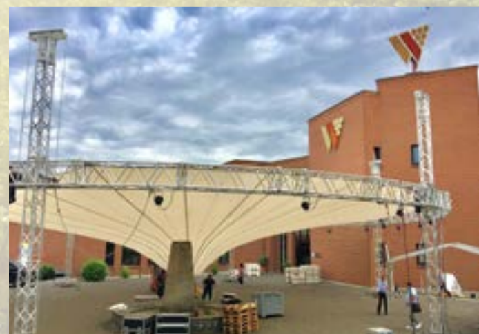
Startrampe - Zelt Dach wird an Säulen hochgezogen
