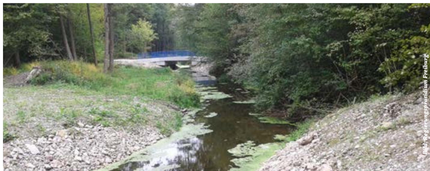
So sieht das geöffnete Schlutensystem im Rheinwald nach der Baufertigstellung nun aus – auch ein Refugium für Kleinlebewesen
