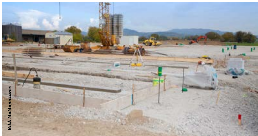
Bald schon wird das neue Baugebiet „Vogesenstraße II“ erschlossen
