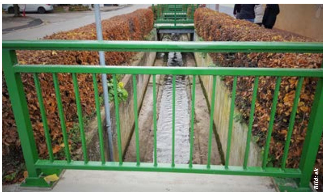
Jechtingen ist ein echtes Brückendorf mit 42 Brücken im Ort
